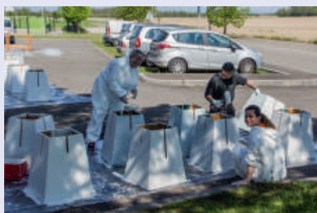
← Chantier Divers travaux de peinture
