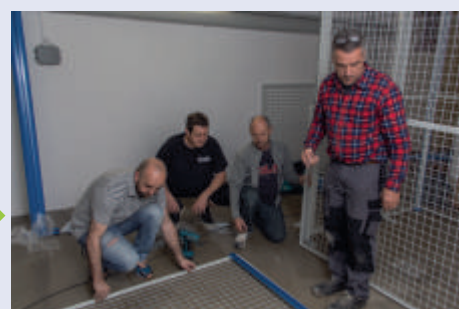
Chantier Aménagement de box de rangement au sous-sol de la salle polyvalente →
