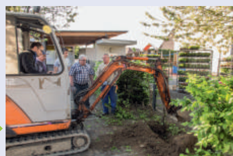
Chantier Mise en place d'un tableau d'affichage devant l'école →
