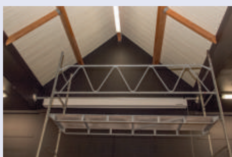
← Chantier Installation d'un écran dans la salle polyvalente
