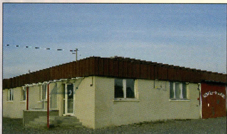
Les locaux du CIS de NAMBSHEIM, 7 rue du grand canal d'Alsace
